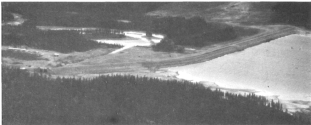
Fig 8 Flåsjödammet. Vattenregleringar är kartområdets mest påtagliga exempel på antropogen påverkan. Flåsjödammet. The most obvious indication of human activity in the area is the damming of lakes.
